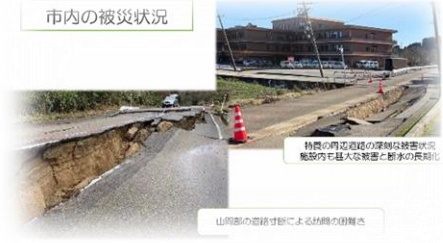
市内の被災状況
